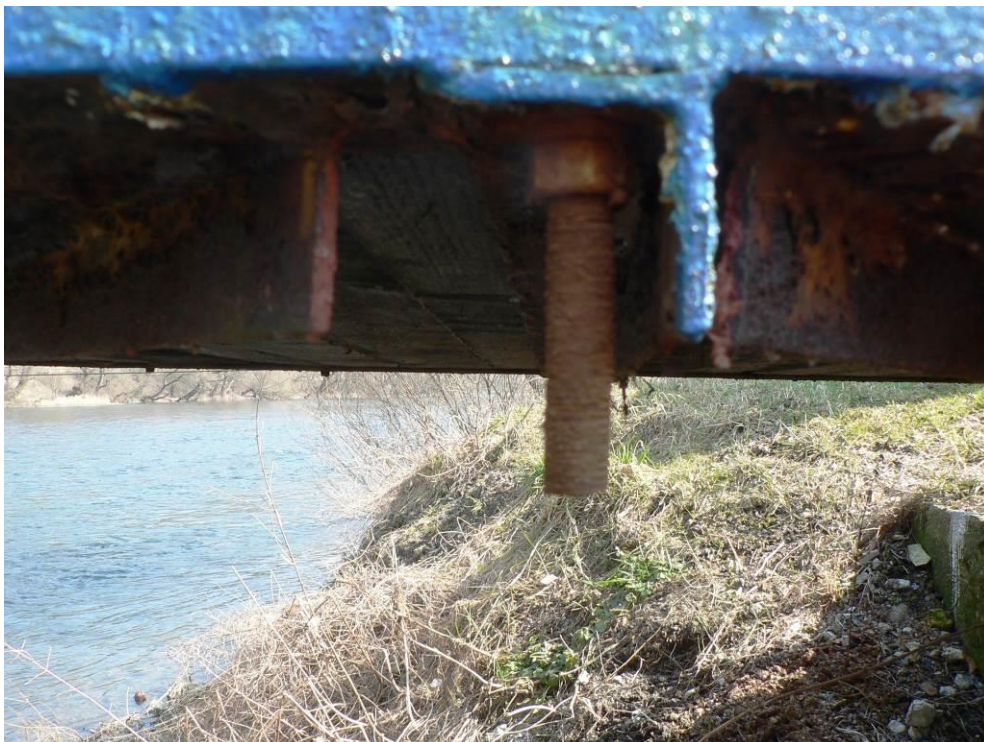
Obr. 4 - 4 Skorodovaný závit zvislého závěsu, nemožnosť rektifikácie
