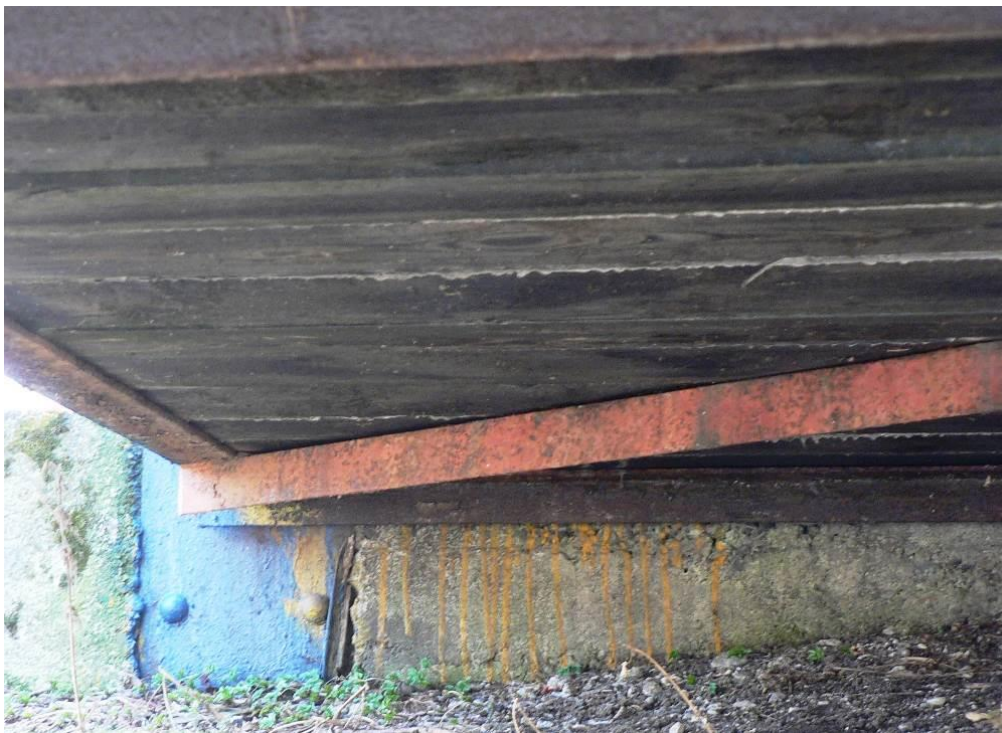
Obr. 4 - 8 Korózia ocelových prvkov mostovky
