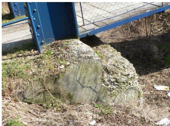
Obr. 4 - 1 Rozpadanie betónových základov
