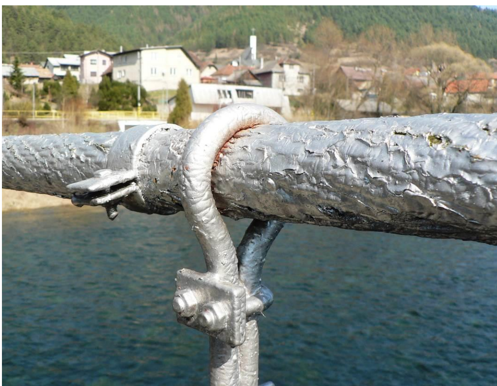
Obr. 4 - 5 Otláčenie lana zvislým závesom, korózia nosného lana
